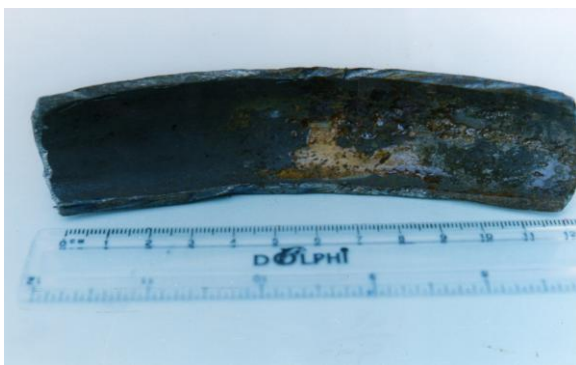
Fig. 4 Wall Thinning (Erosion)
